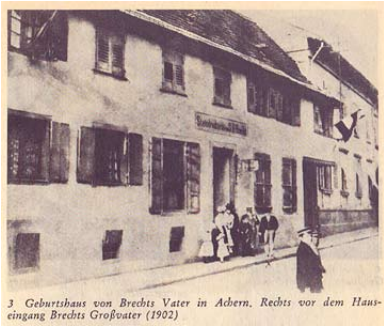
Abb. 2: Dieses Foto zeigt das Acherner Haus im Zustand von 1902 (nach Frisch/Obermeier, wie Anm. 14, „Foto 3“).
